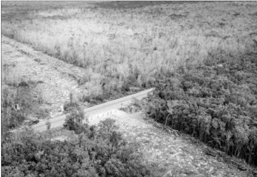
► Parte del tramo 5 del Tren Maya, en Quintana Roo, que ha generado críticas al Presidente. Foto Cuartoscuro
