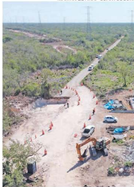
Tramo tres del Tren Maya en Yucatán
