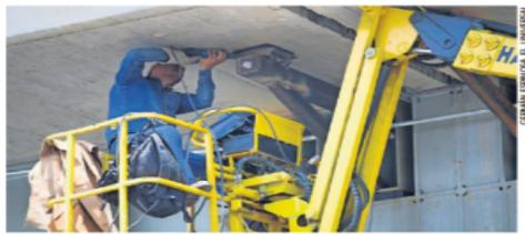
Las labores que se realizan son de soldadura y colocación de placas metálicas debajo de las trabes que cargan el Trolebús.
