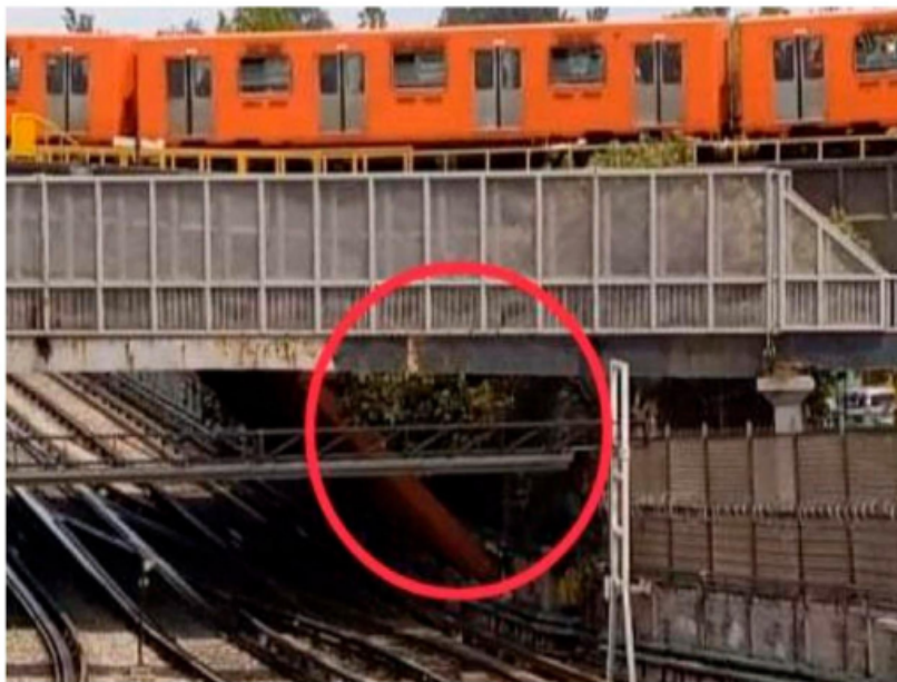
Se colocaron puntales sobre el cajón de la Línea 5, obstruyendo el paso sobre la vía 1 en la zona de maniobras de la línea amarilla.
