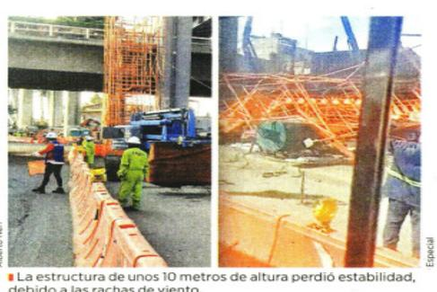
La estructura de unos 10 metros de altura perdió estabilidad, debido a las rachas de viento.
