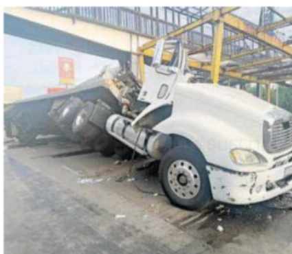
Al volcar rompió los soportes del puente peatonal.
