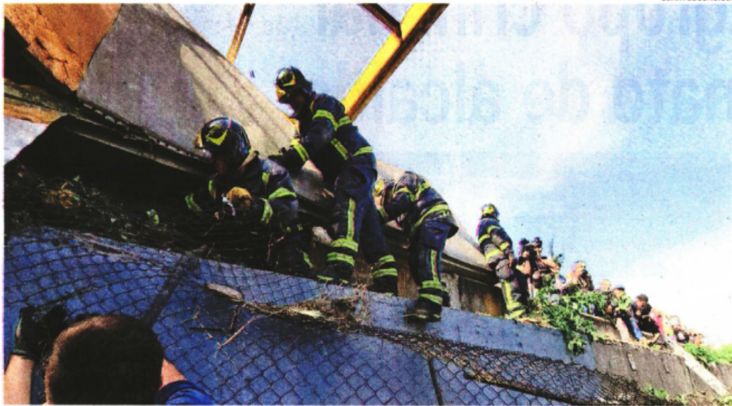
Trabajadores apoyaron en la remoción de escombros y restauración por 24 horas.
