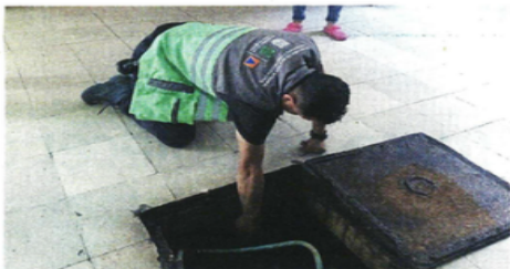
Paralelo a los estudios, en Nonoalco se realizan labores de desazolve en la red de drenaje.
