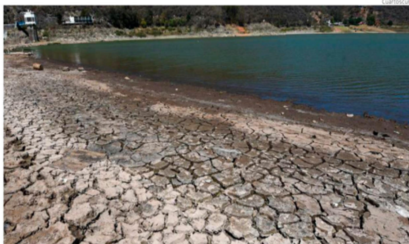
Aspecto de la Presa Miguel Alemán Valdés
