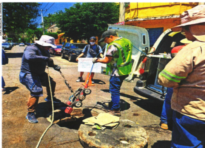
Personal del Sistema de Aguas de la Ciudad de México ingresó una cámara de inspección de circuito cerrado para revisar las tuberías aledañas al pozo.
