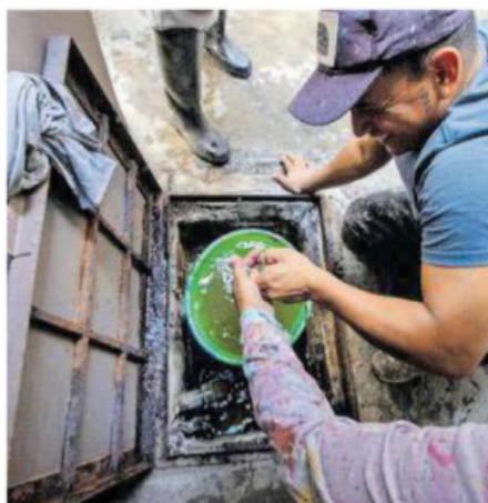
En la desinfección se utiliza cloro
