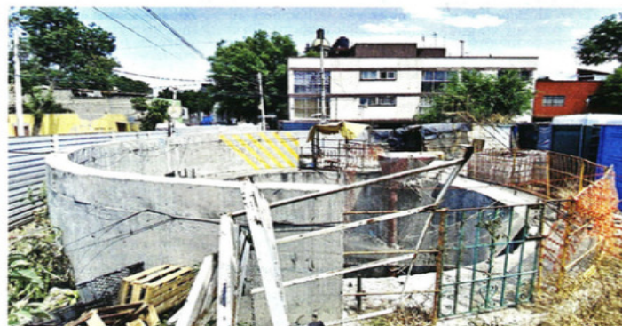
SIN AVANCE. A lo largo del trazo que expandirá la Línea 12 pueden observarse lumbreras, que son los accesos al nuevo tramo subterráneo.
