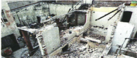
■ Un inmueble catalogado por su valor patrimonial es objeto de una demolición.
