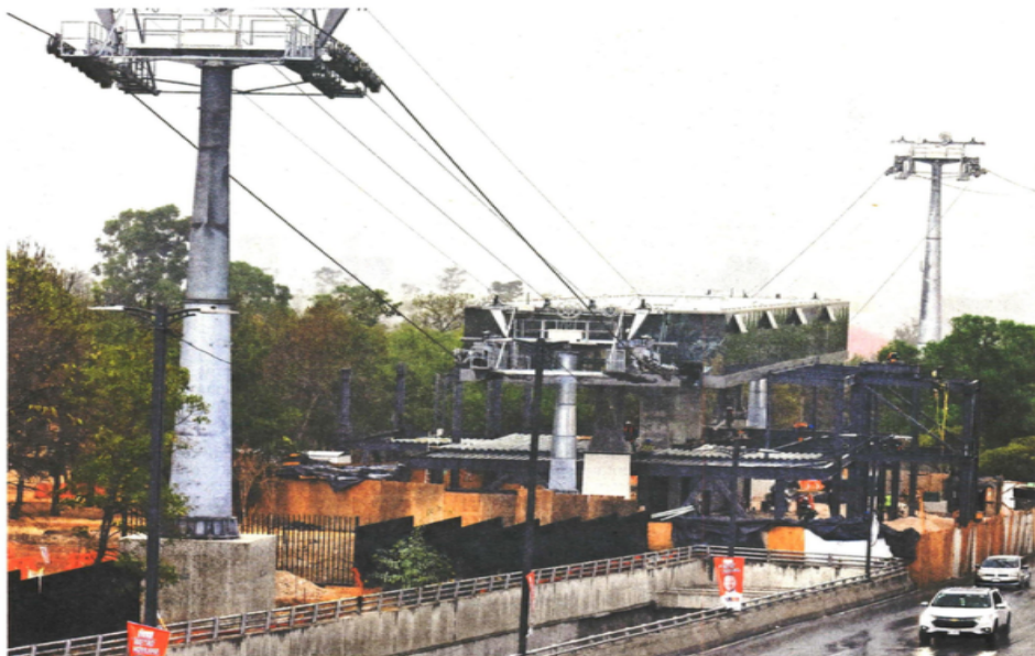
Se construyeron 40 torres a lo largo de los 5.5 kilómetros de trayecto de la Línea 3 del Cablebús.
