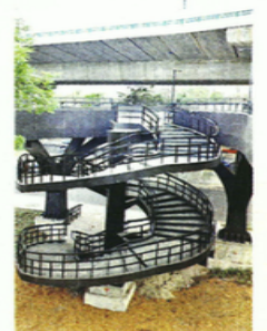
■ La Calzada cuenta con escaleras para descender a Periférico.
