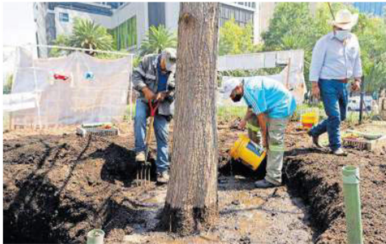
Continúan los trabajos. / FOTO: @SEDEMA
