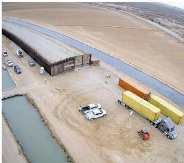
Los trabajos iniciaron la mañana de ayer
