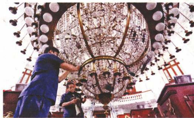
Al candil le hacen dos tipos de mantenimiento; el corto consiste en limpiar los focos y el largo en quitarlos y pulirlos. Éste dura 15 días.
