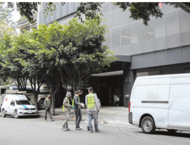
Así luce actualmente Sinaloa 43 con la presencia de trabajadores
