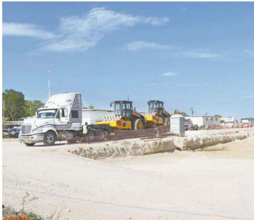
Las obras avanzan en el tramo de Palenque, Chiapas
