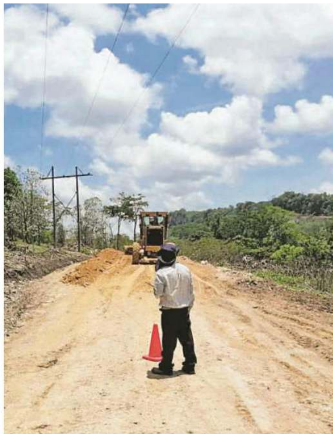
Una carretera en construcción en la zona
