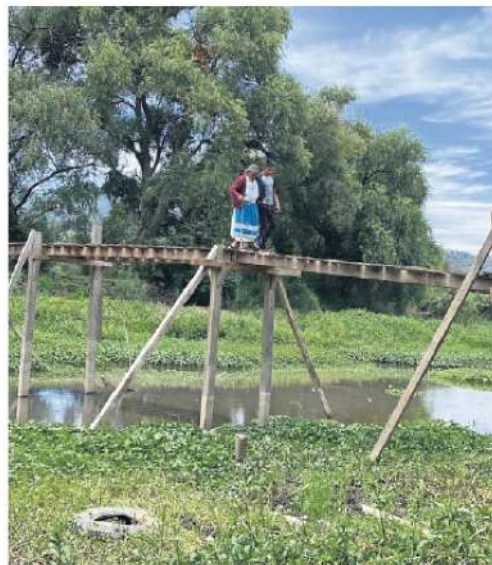
En Urandén, la gente ha construido puentes para conectarse y trasladar víveres; antes lo hacían en lancha.
