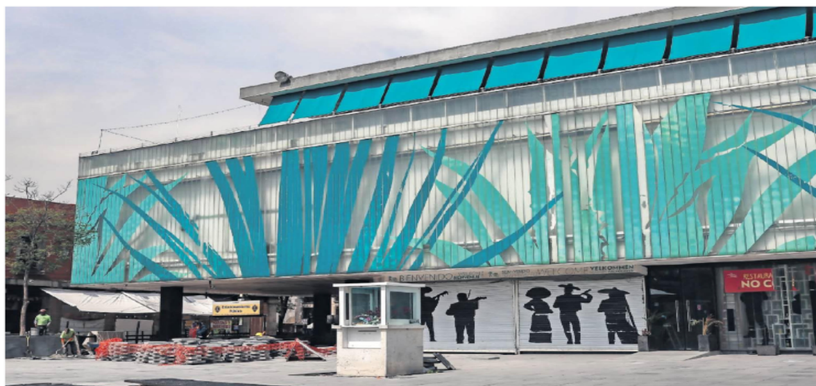
La renovación de Garibaldi inició en junio pasado. Forma parte de las cinco etapas de intervención en el Centro Histórico.
