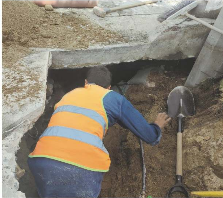
Iniciaron trabajos para sellar los túneles hallados el fin de semana
