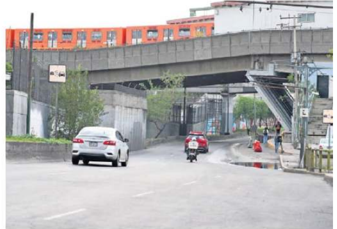
La Secretaría de Obras ha colocado puntales para reforzar el tramo elevado de la Línea 9 del Metro en Pantitlán.
