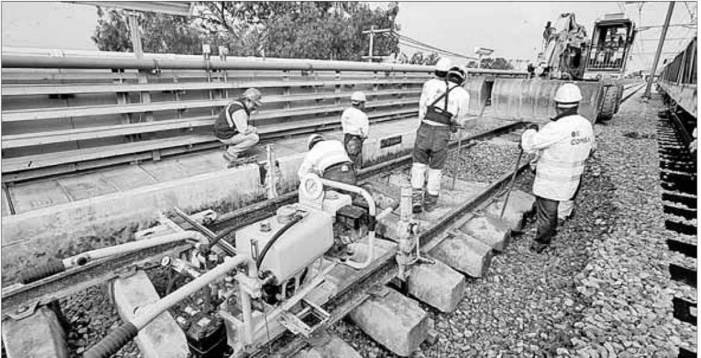
▲ Trabajos de rehabilitación de la línea 12 del Metro, tras el cierre de 11 estaciones para reforzar el tramo elevado por presuntas fallas estructurales. En esta imagen, labores entre las estaciones Olivos y Tezonco. Foto Carlos Ramos Mamahua
