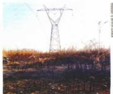
La estructura de las torres de transmisión no muestra signos de daño por fuego.
