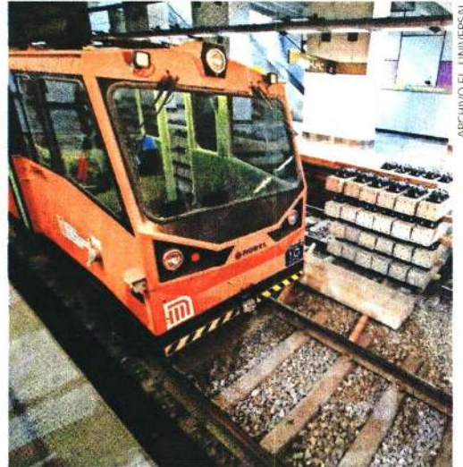
El Gobierno local destinará 215 millones de pesos para el reforzamiento de la Línea 12 del Metro.
