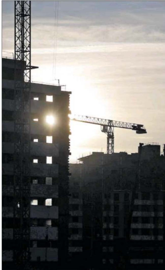
Bloque de viviendas en obras en Madrid el 25 de noviembre. / MARISCAL (EFE)
