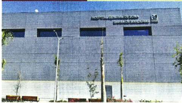
HOSPITAL GENERAL DE ZONA EN BAHÍA DE BANDERAS
