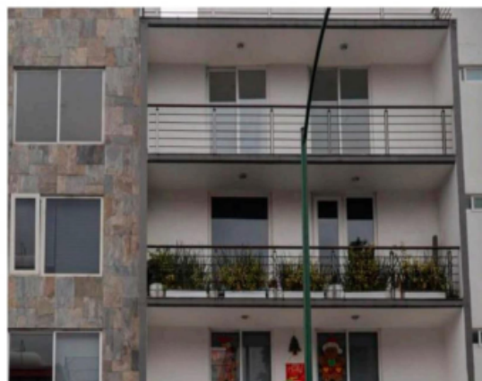
Cada uno de los predios está sometido a valoraciones impuestas por el Instituto para la Seguridad de las Construcciones, conforme al uso de suelo autorizado.
