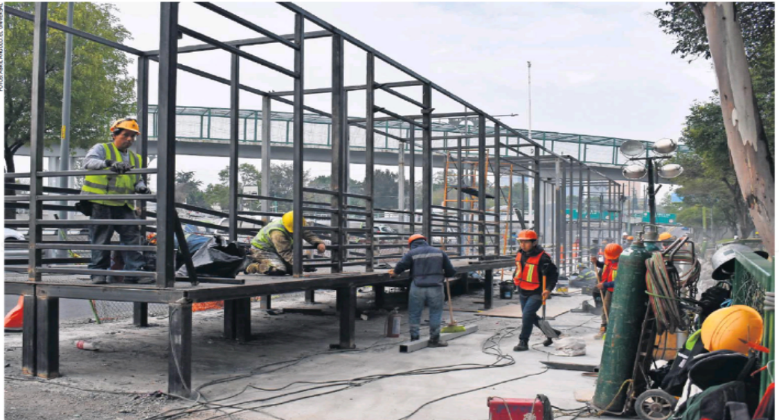
En Viaducto Río de la Piedad, frente a la estación Velódromo, soldadores trabajan en el área de ascenso y descenso de unidades del Metrobús.
