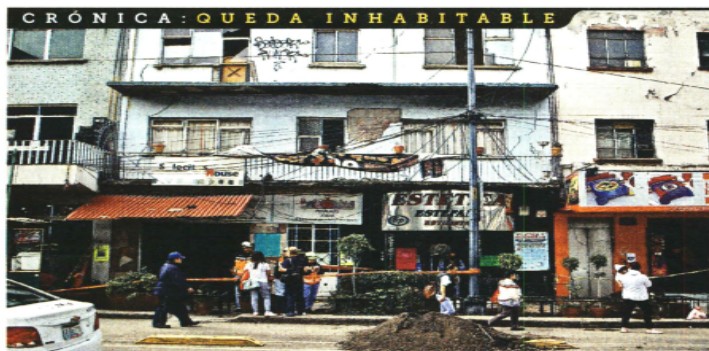
SE RESISTEN A SALIR. El edificio de Revolución 959 data de los años 50. Uno de los dos locales comerciales con los que cuenta el inmueble aún se encuentra ocupado y abierto al público.
