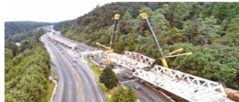
Foto: Especial Aspecto de los trabajos para colocar una estructura metálica de 253 toneladas y 44 metros de longitud sobre la autopista.
