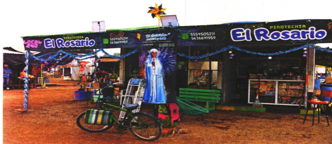
El tianguis pirotécnico de San Pablito se reconstruyó con mejores medidas de seguridad y bajo supervisión de la Sedena.
