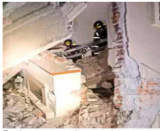
Bomberos retiraron los escombros sin maquinaria, mientras realizaban la búsqueda de una persona, la cual fue hallada sin vida.
