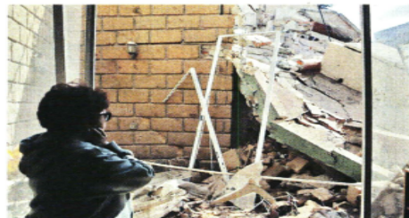
Los escombros de la casa 3 en Providencia 1017.
