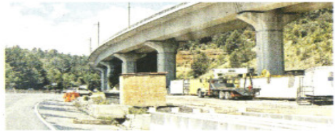
■ El cierre es por las obras del Tren Interurbano, que conecta a la CDMX con el Edomex.
