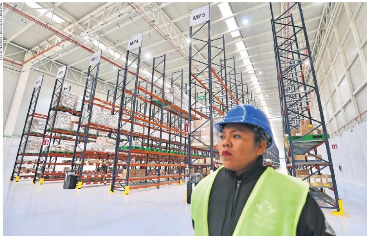
La Megafarmacia del Bienestar cuenta con seis baterías de racks, cada una de 102 metros de largo, siete de alto y cinco niveles, con capacidad de carga de hasta mil 600 kilos.
