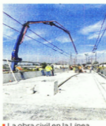
La obra civil en la Línea Dorada fue concluida el viernes.
