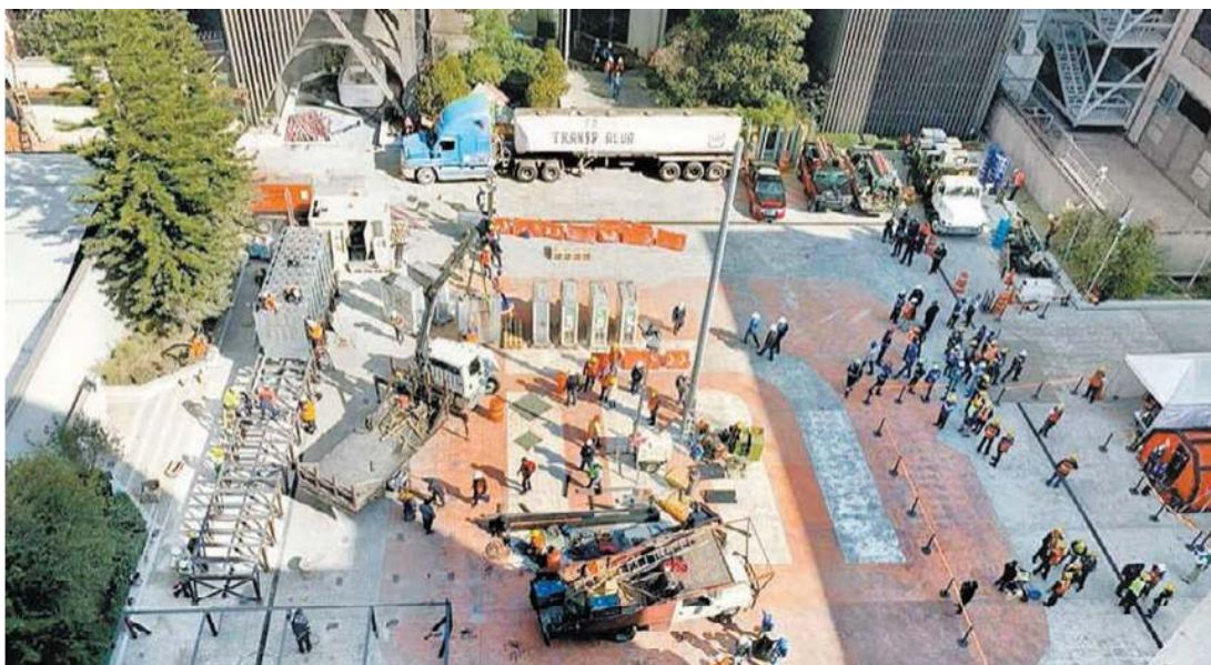
Labores para instalar el centro de energía que servirá para las líneas 1, 2 y 3. ESPECIAL
