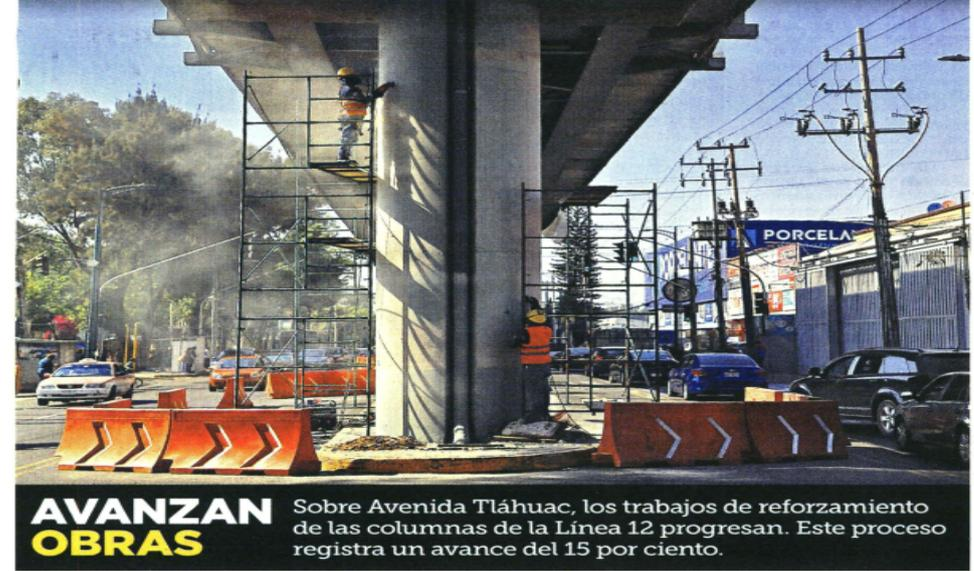
**AVANZAN OBRAS** Sobre Avenida Tláhuac, los trabajos de reforzamiento de las columnas de la Línea 12 progresan. Este proceso registra un avance del 15 por ciento.
