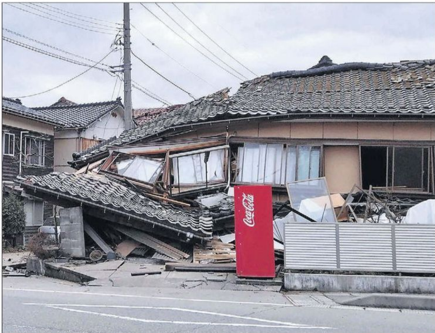
Una casa completamente dañada ayer por un terremoto en Wajima, prefectura de Ishikawa, Japón. AP
