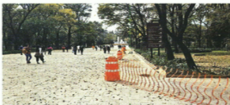
Sobre Calzada Juventud Heroica, los trafítambos y la malla delimitan la zona donde todavía hay trabajos pendientes.
