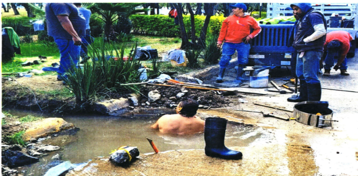
Naucalpan.— Trabajadores de OAPAS nadaron y bucearon para reparar una megafuga de agua potable que dejó sin abasto a colonos de Ciudad Satélite durante 48 horas. Este miércoles el suministro se normalizó. | METRÓPOLI | A20
