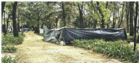
Así luce el corredor de acceso al Metro Chapultepec, otro de los frentes de obra de la remodelación.
