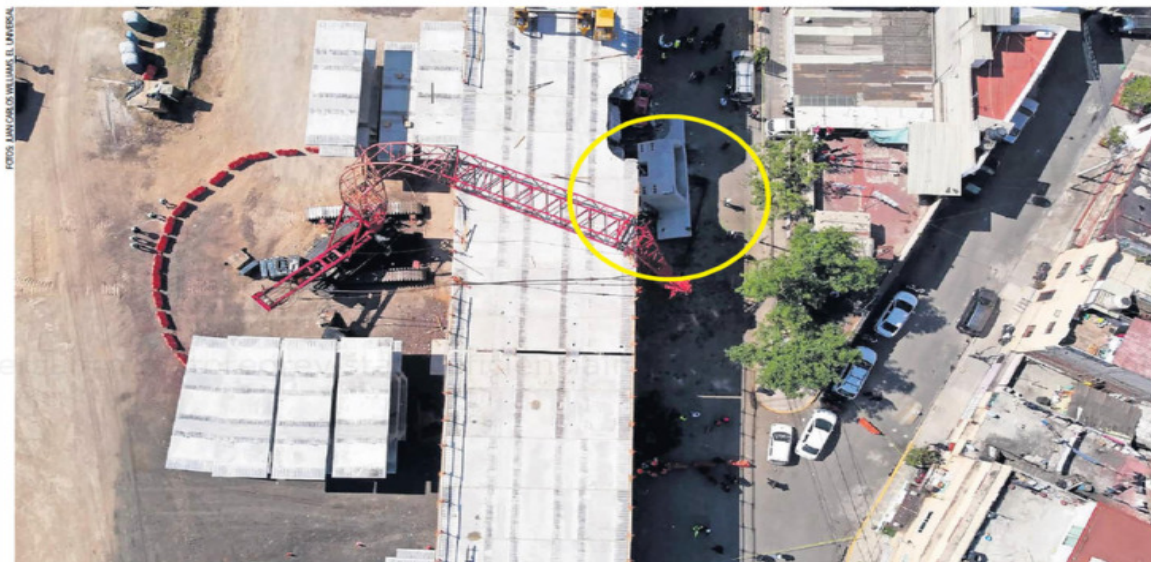
La estructura que se cayó era trasladada para ser montada en el apoyo 18. Se investiga si la falla se debió a un error en la operación o de la grúa.
