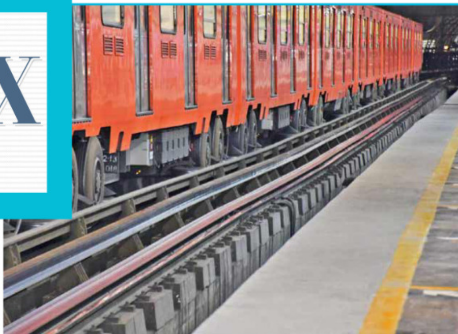
• REMOZAR. Se van a intervenir 300 bloques de concreto que sostienen la vía.
