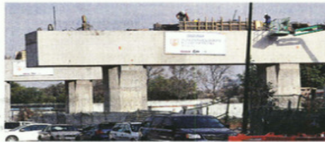
■ Aunque la instalación de dovelas se suspendió, trabajadores operaron ayer sobre el viaducto.
