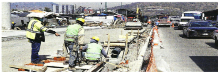
Los trabajos en la zona comenzaron en noviembre de 2020.
