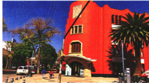
La construcción del hotel representa la segunda etapa del proyecto de rescate del Frontón México, que comenzó en 2016, argumentan.
