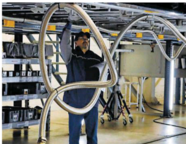
Trabajadores en el armado de las unidades.
