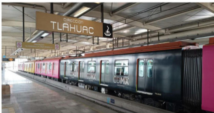
Desde el 31 de diciembre del 2023, la obra civil de la rehabilitación y reforzamiento fue concluida, mientras que en los días posteriores, el sistema entró en una etapa de pruebas de carga
