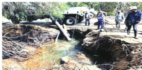
El Organismo de Cuenca Aguas del Valle de México de la Conagua coordina los trabajos de reparación de la fuga del Ramal Teoloyucan.
