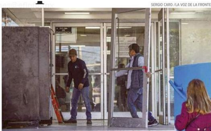
Tras el sismo se inspeccionaron distintos inmuebles del municipio
